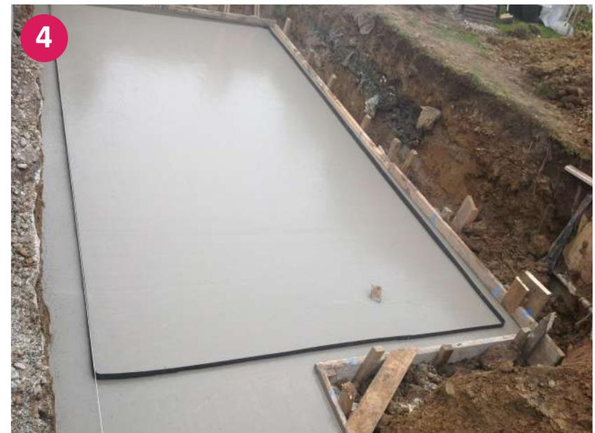
▲ Die Bodenplatte kann mit einem Fugenband für zusätzliche Abdichtung ausgestattet werden.
