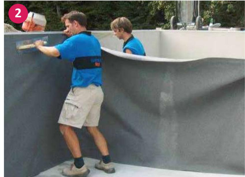
▲ Punktuelle Befestigung der Vliestrennlage mittels Styroporkleber
