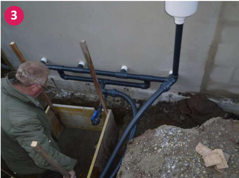
▲ Verrohrung von Düsen, Skimmer und Bodenablauf
