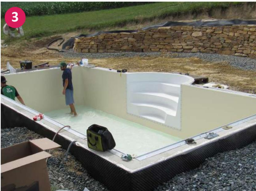
▲ Einhängen des Foliensacks und Anflanschen der Einbauteile
