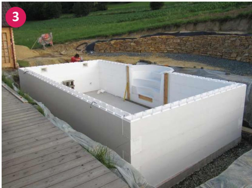
▲ Aufgestelltes Styroporstein Becken mit Römertreppe – ohne Betonfüllung
